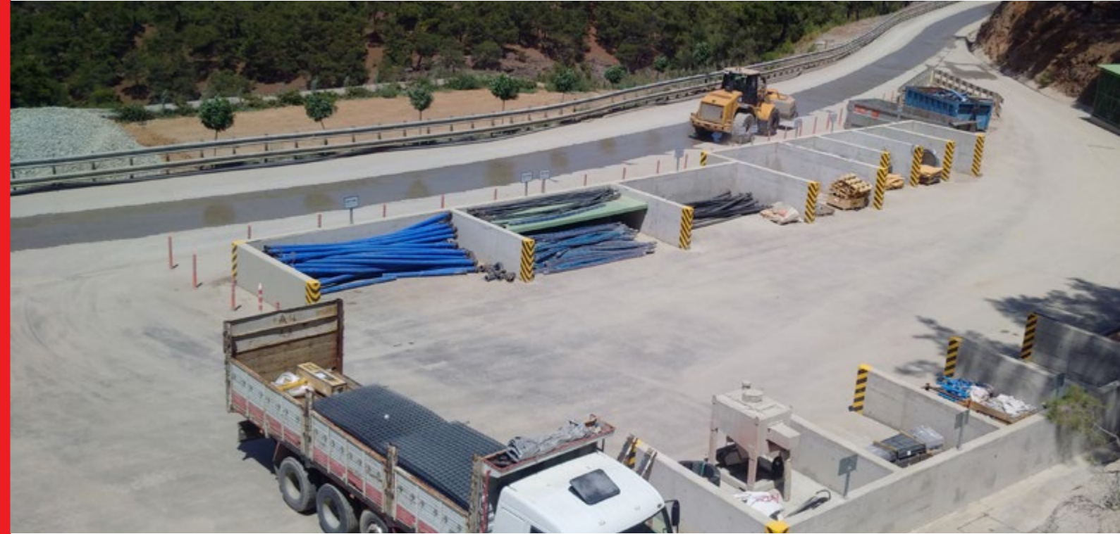
KUZEY PORTAL DEPO VE SAHA BETONU
