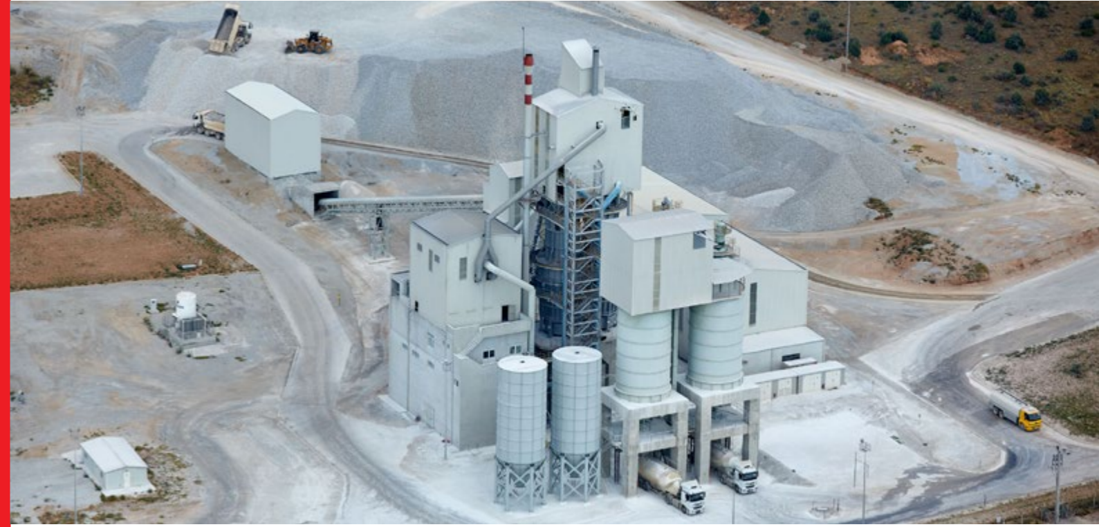
KİREÇ FABRİKASI İNŞAATI
