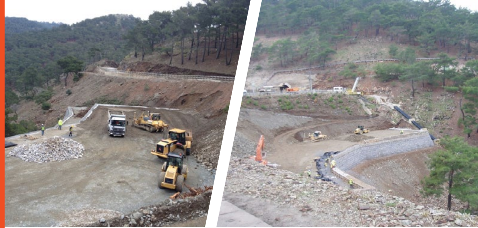
GABİON DUVAR İŞİ
