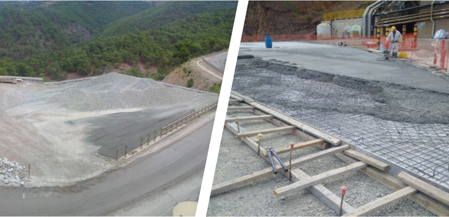
KUZEY PORTAL DEPO VE SAHA BETONU
