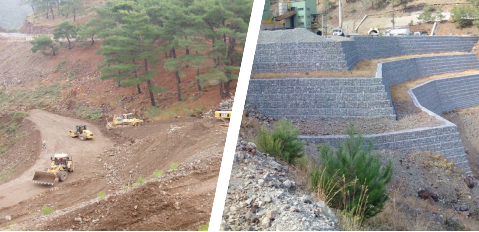
GABİON DUVAR İŞİ
