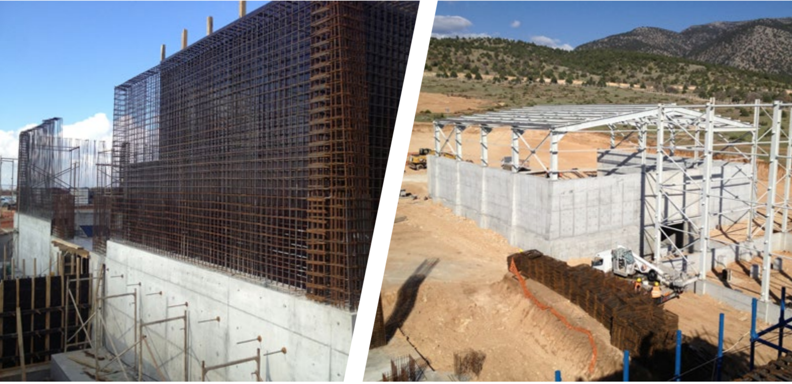
KİREÇ FABRİKASI İNŞAATI
